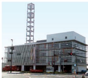
デジタル消防無線システムの導入を進めている岡山市消防局様
