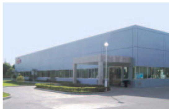
〈上海〉新設した技術棟
